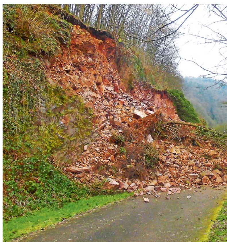
Der Felssturz ereignete sich oberhalb des Zufahrtsweges zur Staustufe bei Mettlach auf der rechten Saarseite. FOTO: HEINZ TEMMES
